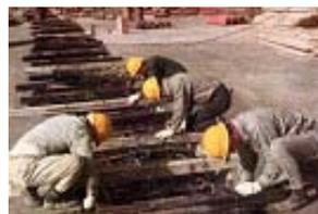
1) 打ち継ぎ用型枠の設置作業
